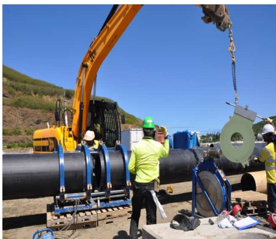
Soudure du tuyau PEHD
