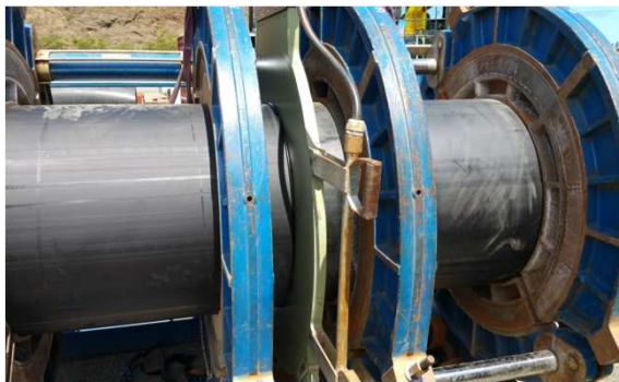
Soudure du tuyau PEHD
