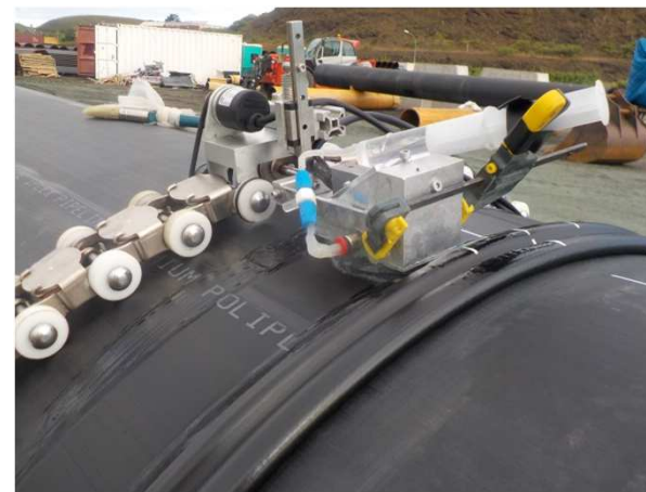
Contrôle et enregistrement des paramètres de soudage
