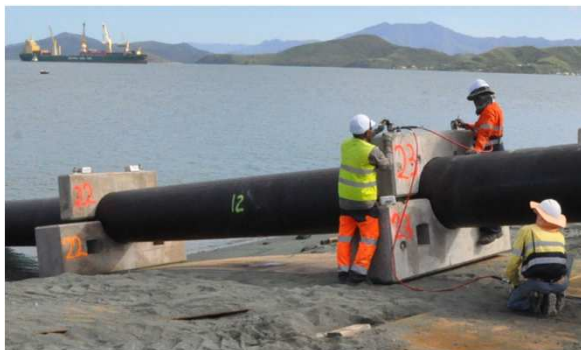
Fabrication de 1186 ballastes béton
