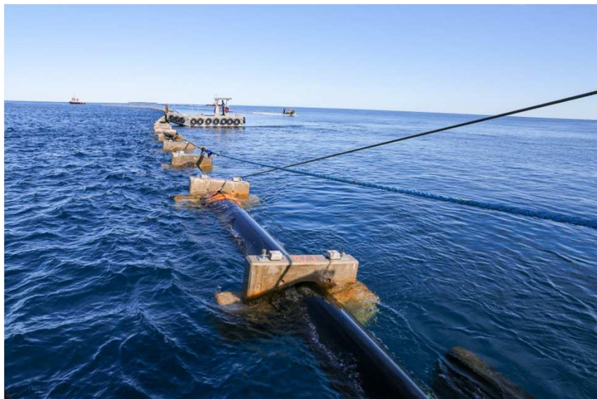
Positionnement du tuyau avant connection
