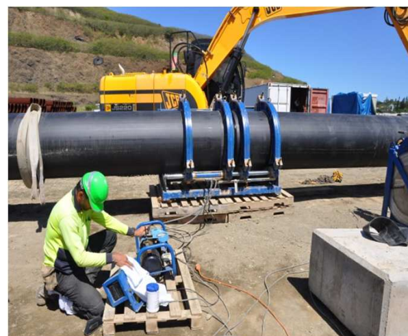
Contrôle et enregistrement des paramètres de soudage
