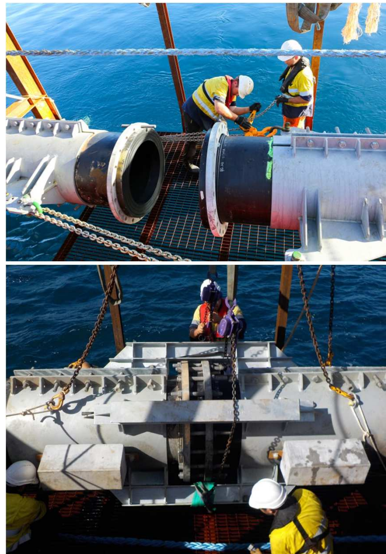
Connection des sections en mer
