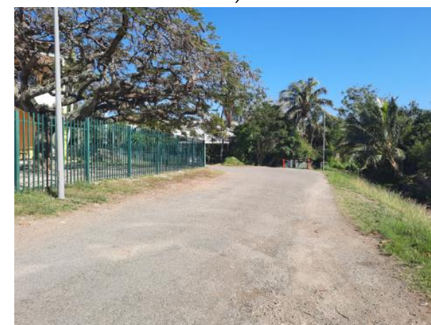
Passage au droit de l'école E. Risbec (tronçon 2 sud)
