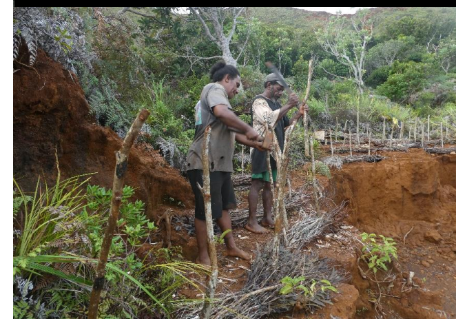
Mise en place d'ouvrages de lutte contre l'érosion
