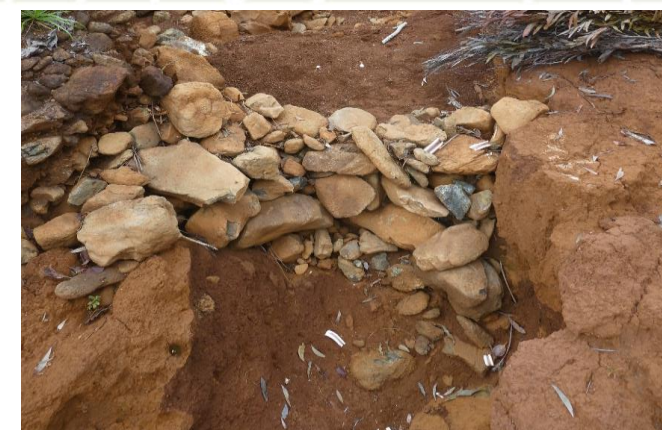
Mise en place d'ouvrages de lutte contre l'érosion
