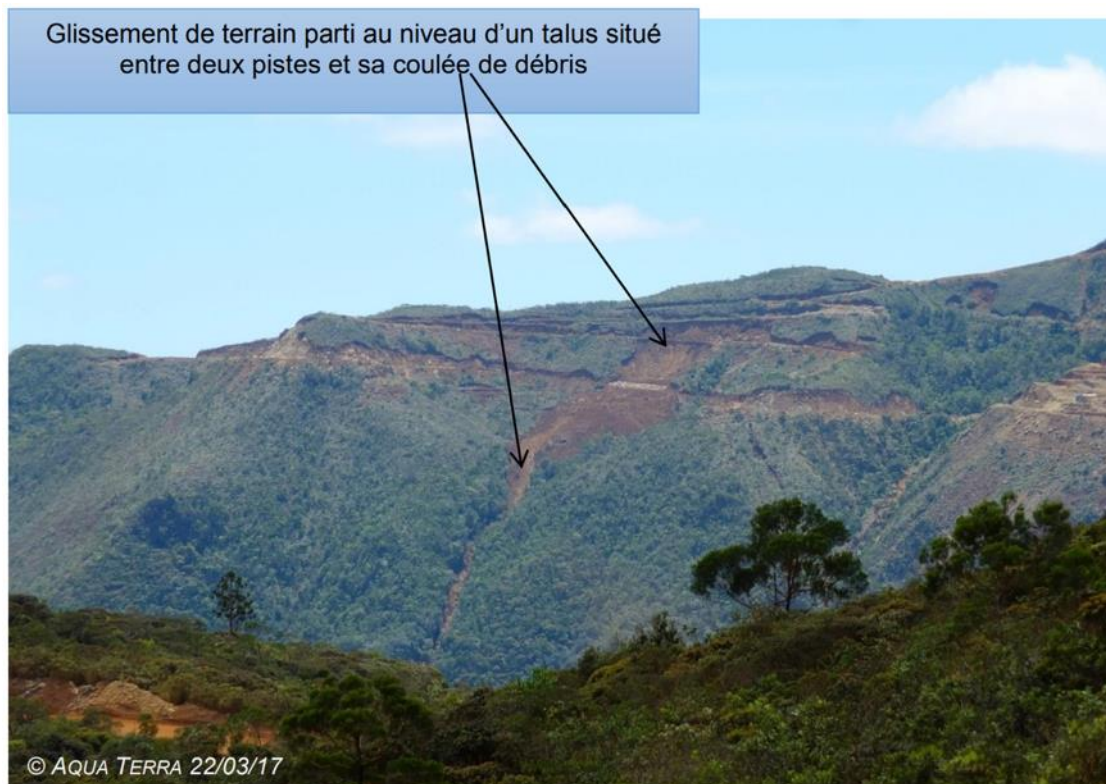
Figure 13 : Photographie illustrant le glissement de terrain sur la piste (Source : Aqua Terra).
