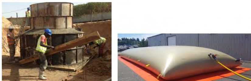
Figure 41 : Construction digesteur de 10 m 3 / Digesteur souple
