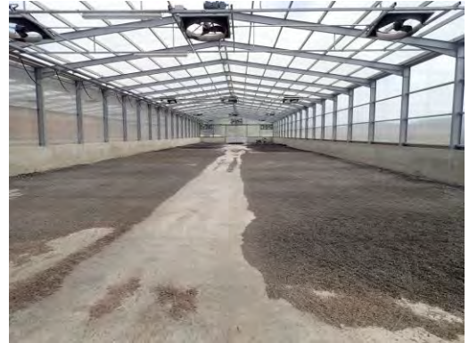
Serre solaire où sont étalées les boues de ES Service
