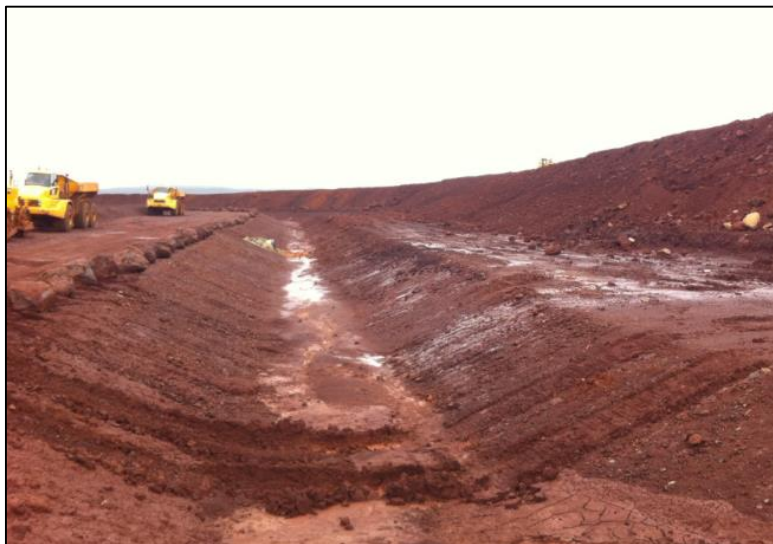
Figure 5 : Fossé de mise hors d'eau en cours de construction
