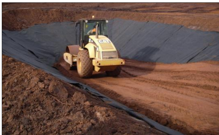
Figure 33 : Travaux de fermeture du dispositif de drainage interne
