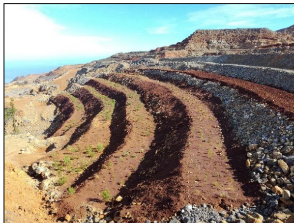
Figure 38 : Recouvrement du talus de la verse DST3 par du top soil (Mine de Ouanzangou)
