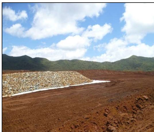
Pose de géotextile et mise en place des enrochements
