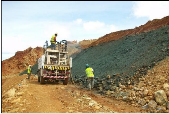
Figure 36 : Chantier de semis hydraulique sur les talus de la verse AC2 (Mine Pinpin)
