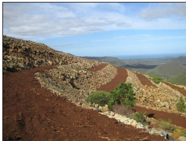
Figure 6 : Verse Thono préalablement préparée par étalage de top soil sur les banquettes avant un chantier de plantations _ Mine Ouazangou
