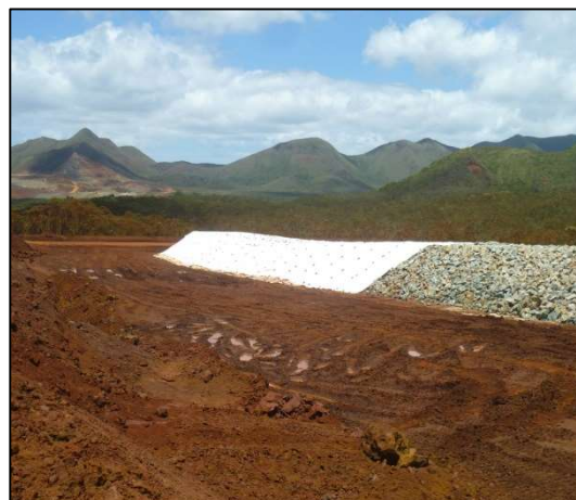
Déroulement du géotextile
