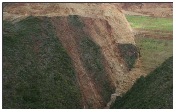
Figure 14 : Butée de pied de la versée AC1 (Site minier : Pinpin, Centre de Poya)
