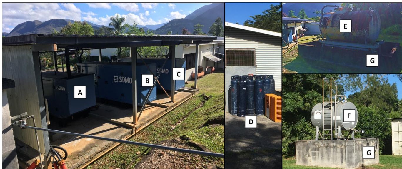
Figure 7 : Générateurs (gauche) et cuves à gasoil (haut-droite : pour les générateurs, bas-droite : pour les véhicules) : A) Générateur pour les poulaillers ; B) Générateur pour l'abattoir ; C) Générateur pour le couvoir ; D) Réserve de bouteille de gaz ; E) Cuve pour les générateurs ; F) Cuve pour les véhicules ; G) Bacs de rétention.
