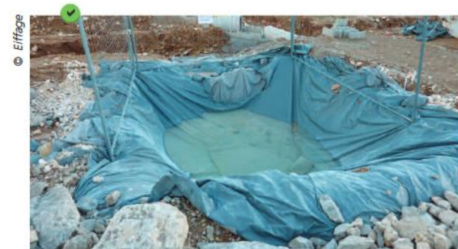
FIGURE 61. Exemple de bassin de décantation des laitances de béton (source : Guide technique AFB)
