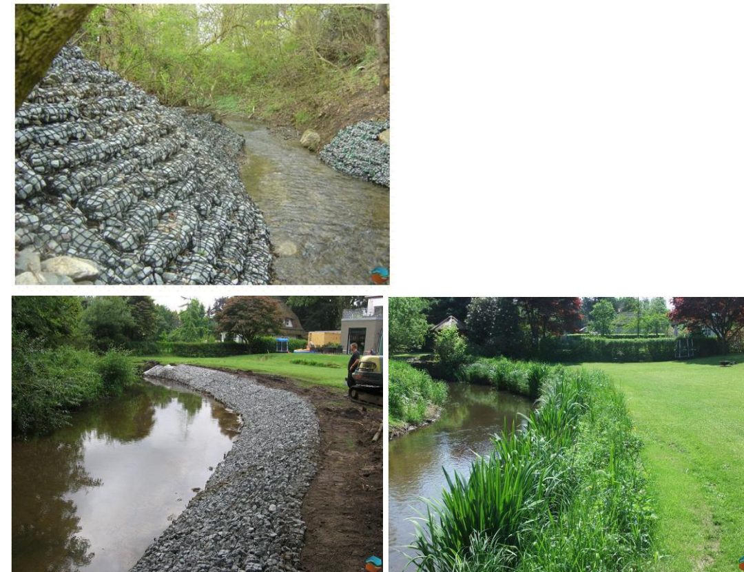
FIGURE 65. Stabilisation des berges par gabions tubulaires ou matelas
