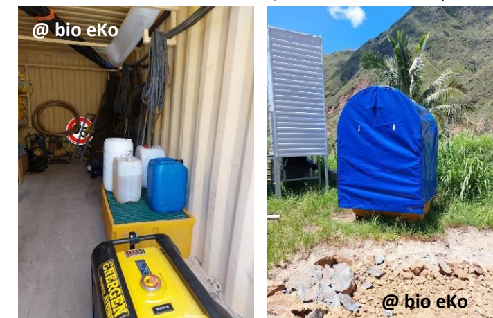
FIGURE 62. Exemple de stockage de produits polluants sur rétention (source : Bio eKo)
