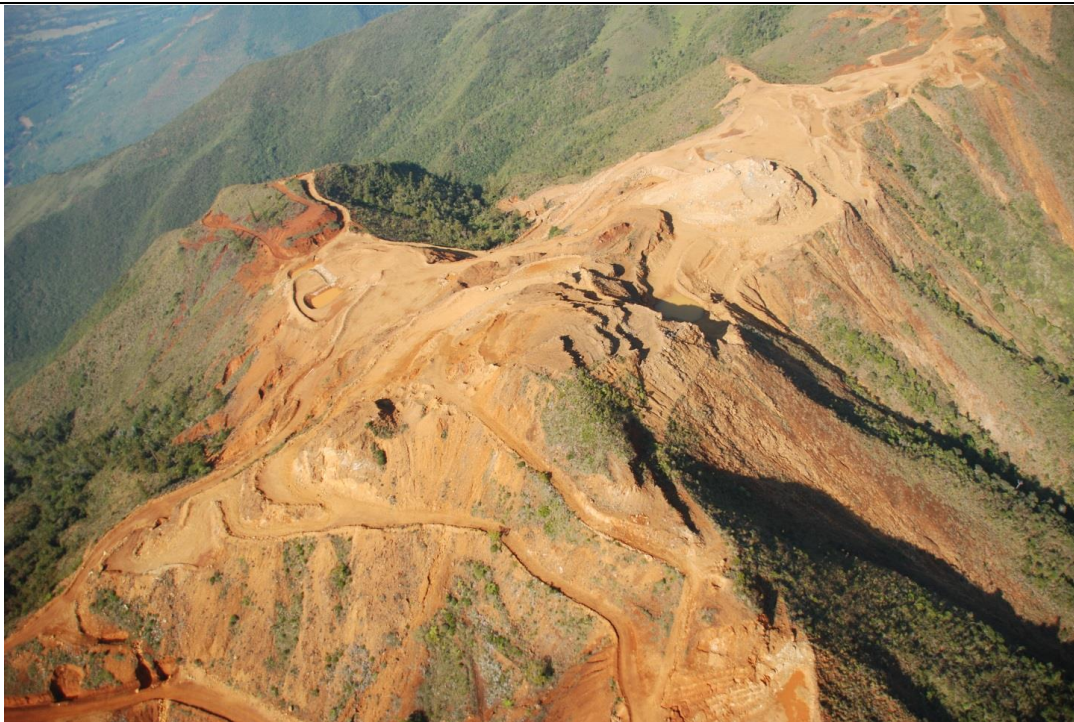
Point de vue 5 - Philofele Ouest
