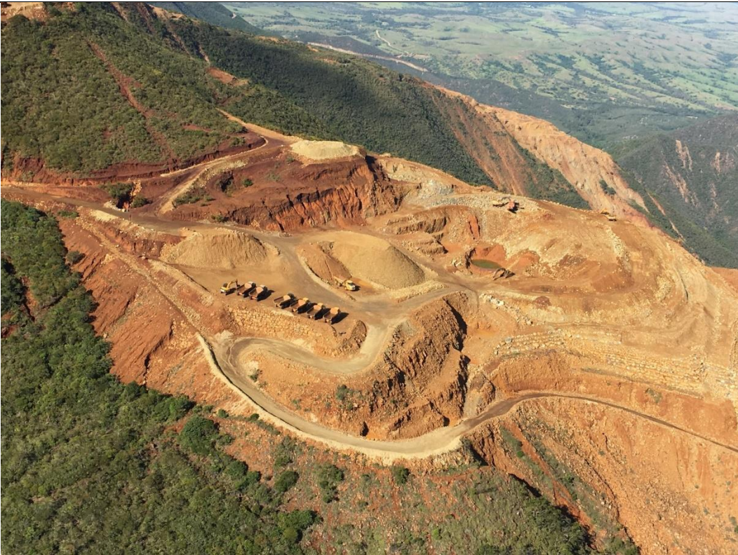
Point de vue 2 –Zone bureaux
