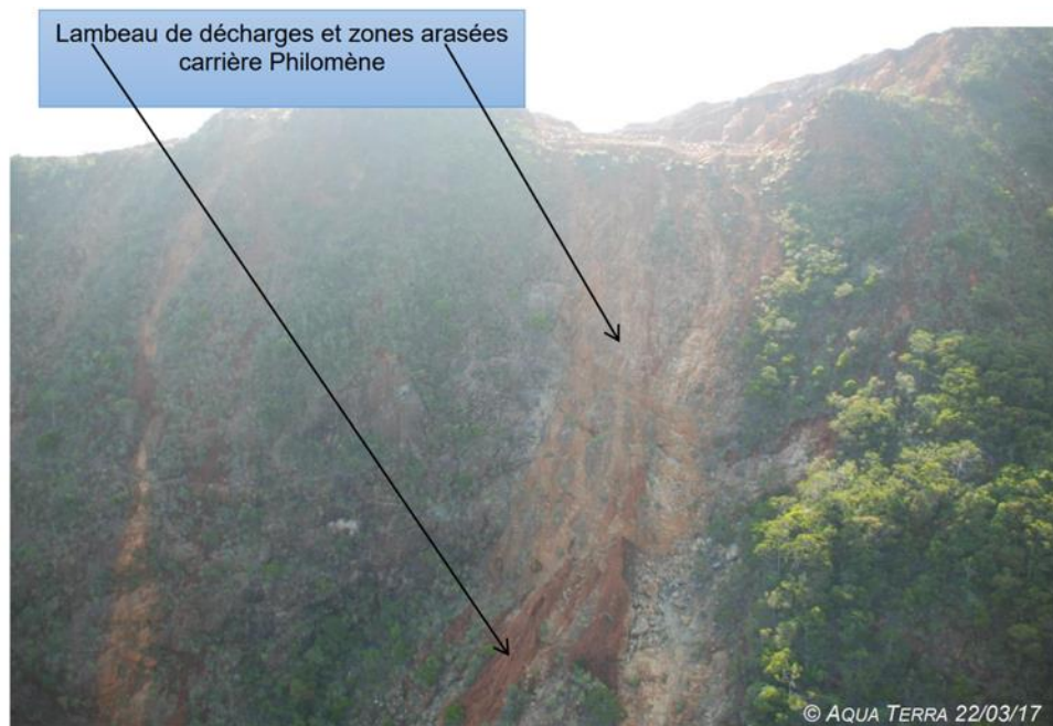
Figure 27 : Photographie illustrant les figures d'érosions sur le versant nord-ouest (Aqua Terra).
