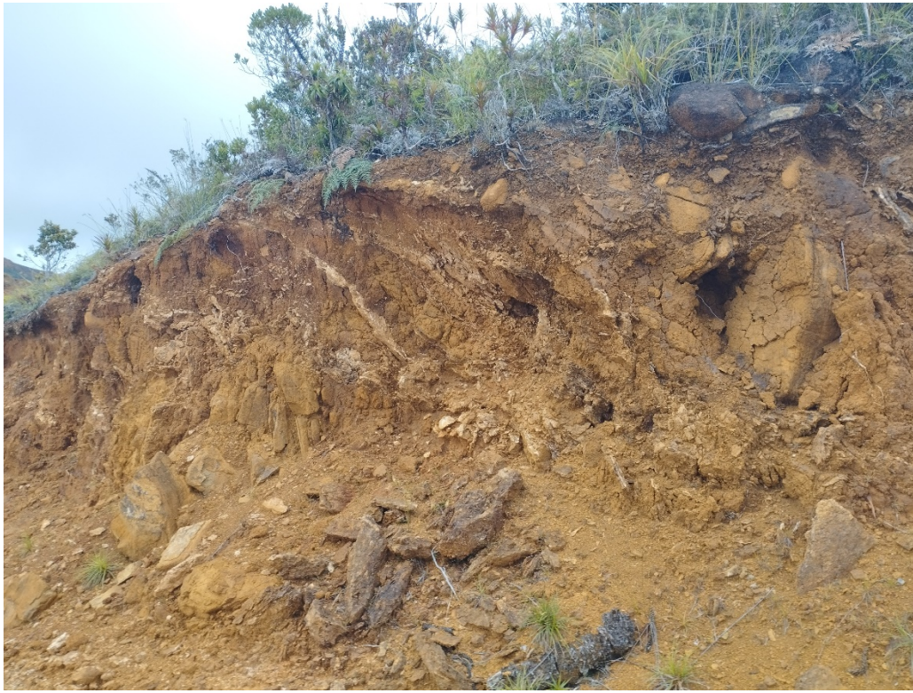
Saprolites à tendance karstique sous fine couche latéritique, orienté N80° et N120°
