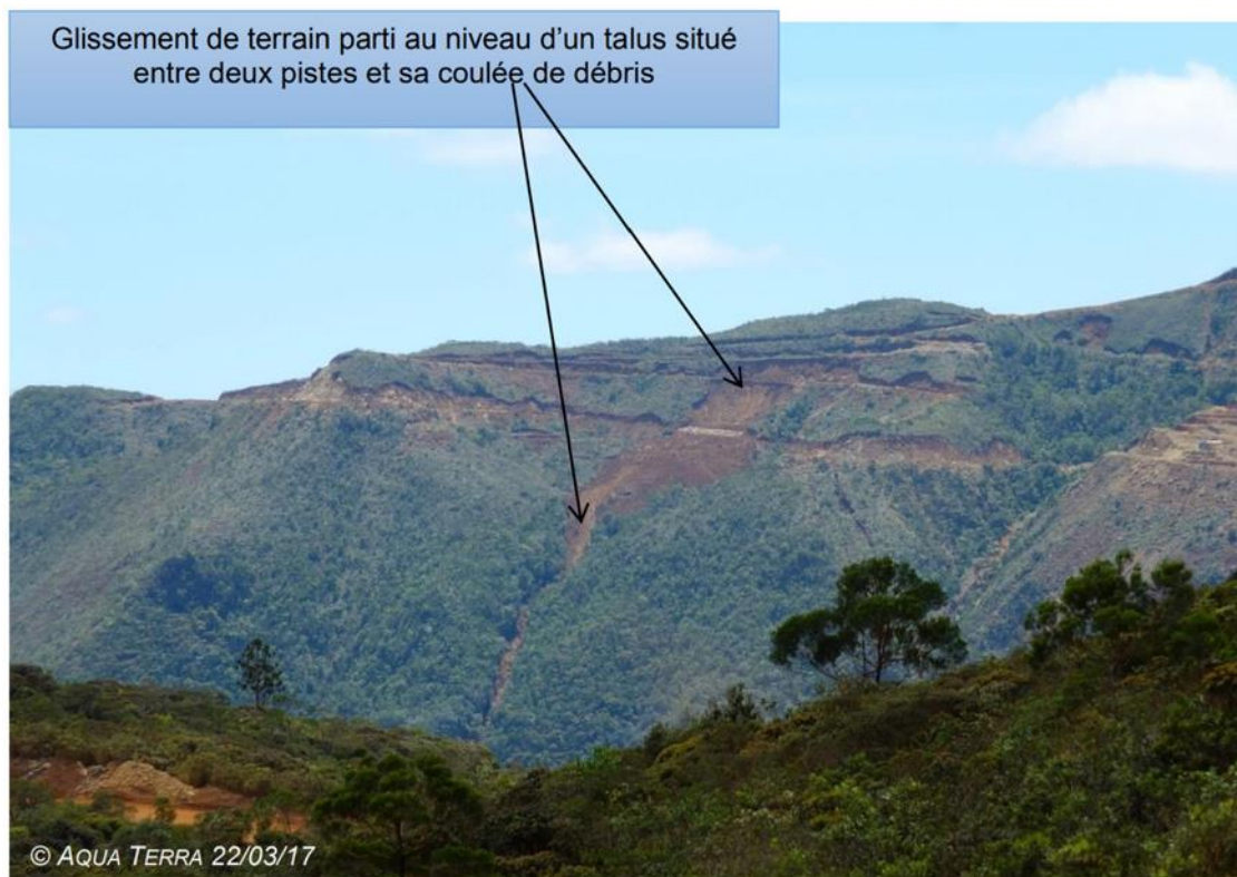
Figure 28 : Photographie illustrant le glissement de terrain sur la piste (Source : Aqua Terra).
