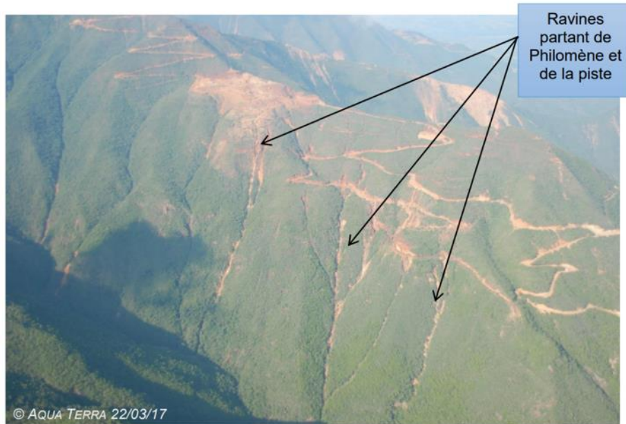
Figure 25 : Photographie illustrant les ravines sur le versant Nord de la concession Philomène (Source : Aqua Terra).
