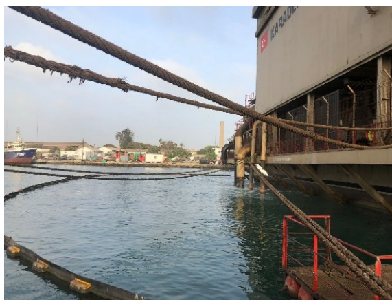
Figure 20 : Mise en place d'un boudin flottant anti-pollution (KPS)
