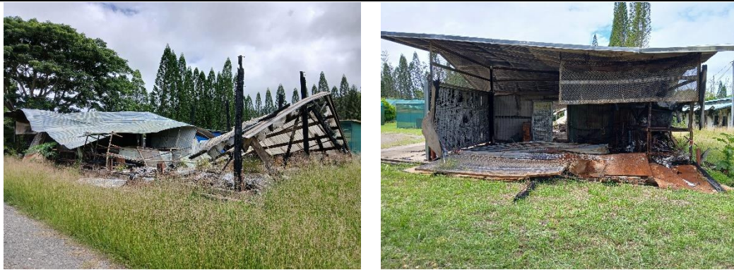
PHOTOGRAPHIES DU BATIMENT
