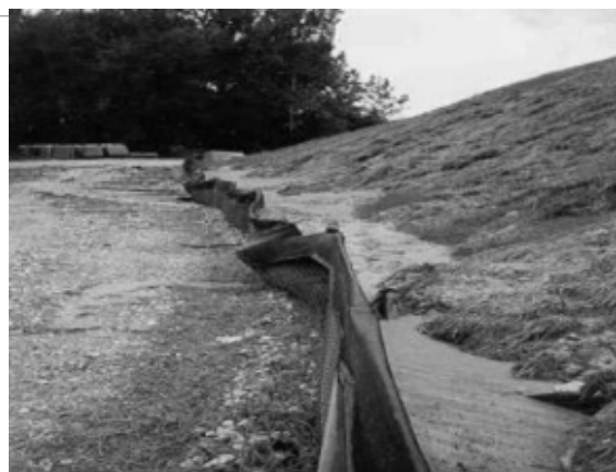
Exemple de barrière à sédiments en géotextile pour un stockage de matériaux.
