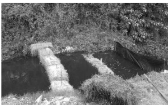
Exemple de barrière à sédiment à ballots de paille suivi d'une barrière à géotextile
