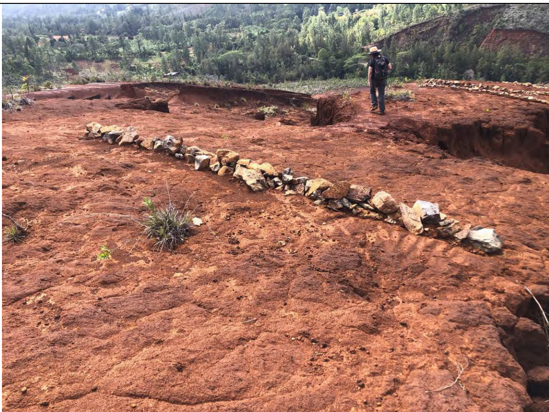
Lot n°1 - Cordon de pierre à traiter
