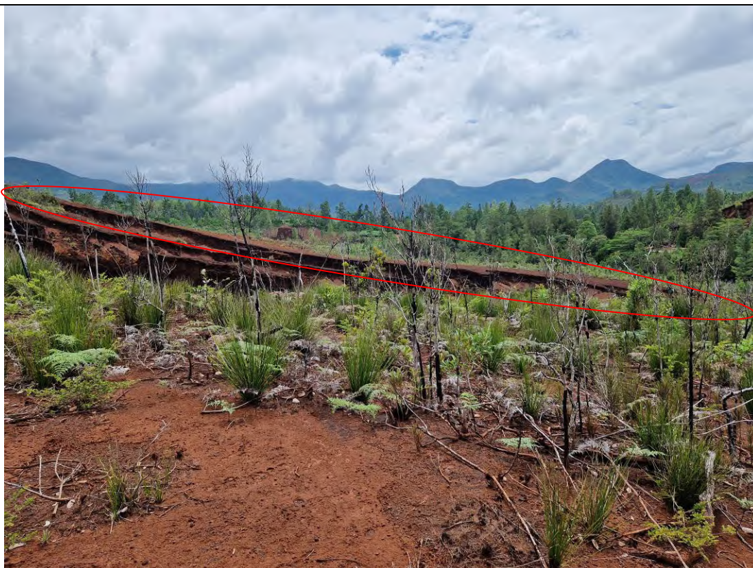
Lot n°1 – Vue depuis la zone C (patches géofilet) vers la zone B de fascines en 2 nd plan (appréciation de la pente)
