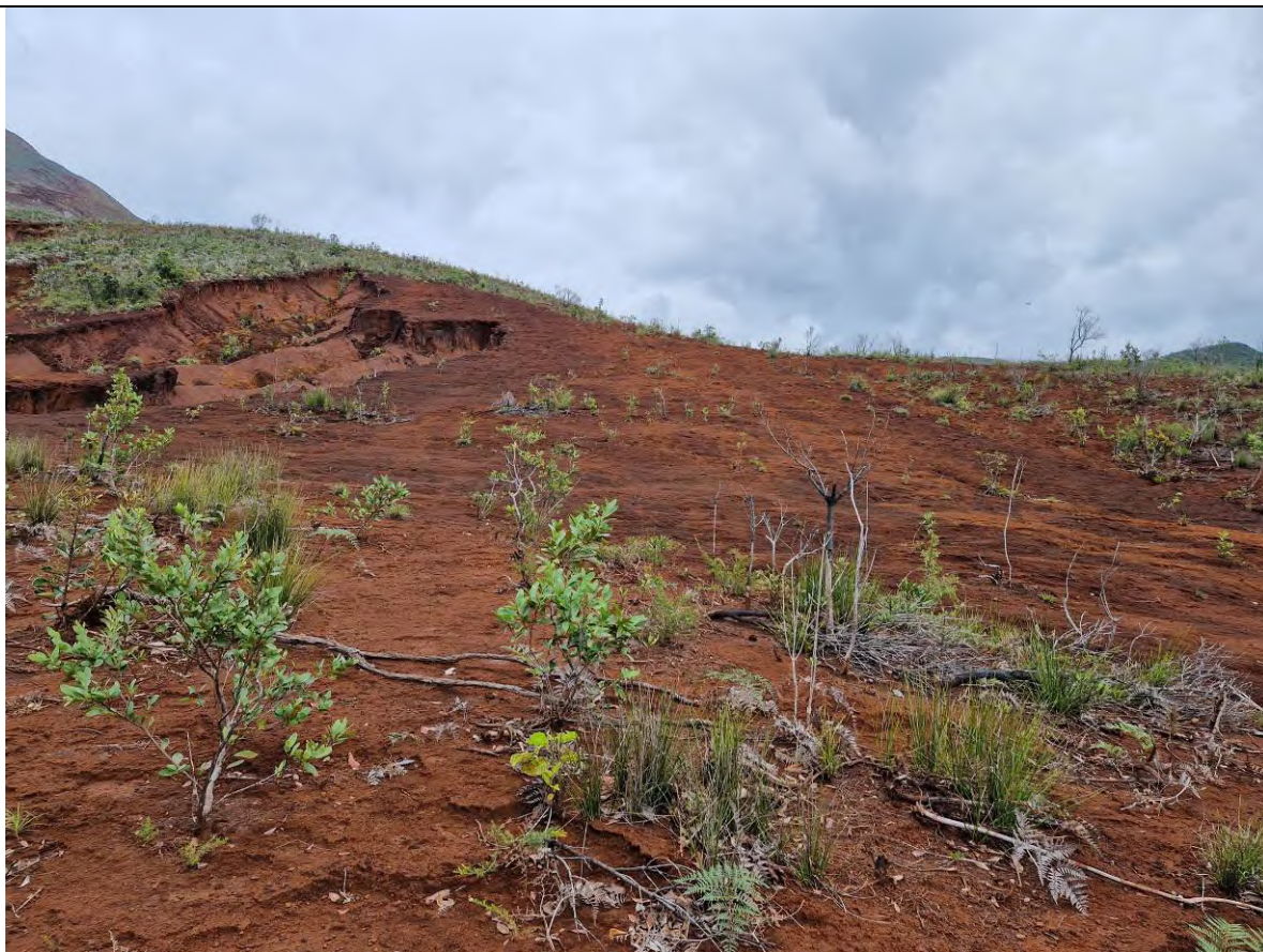
Lot n°1 - Vue de l'aval vers l'amont de la zone B de fascines de gaïacs
