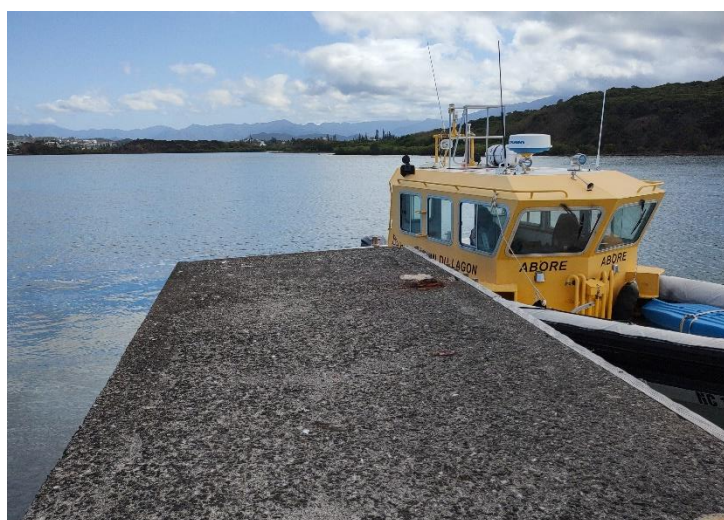
Figure 2 : wharf d'accès à l'îlot Ste Marie
