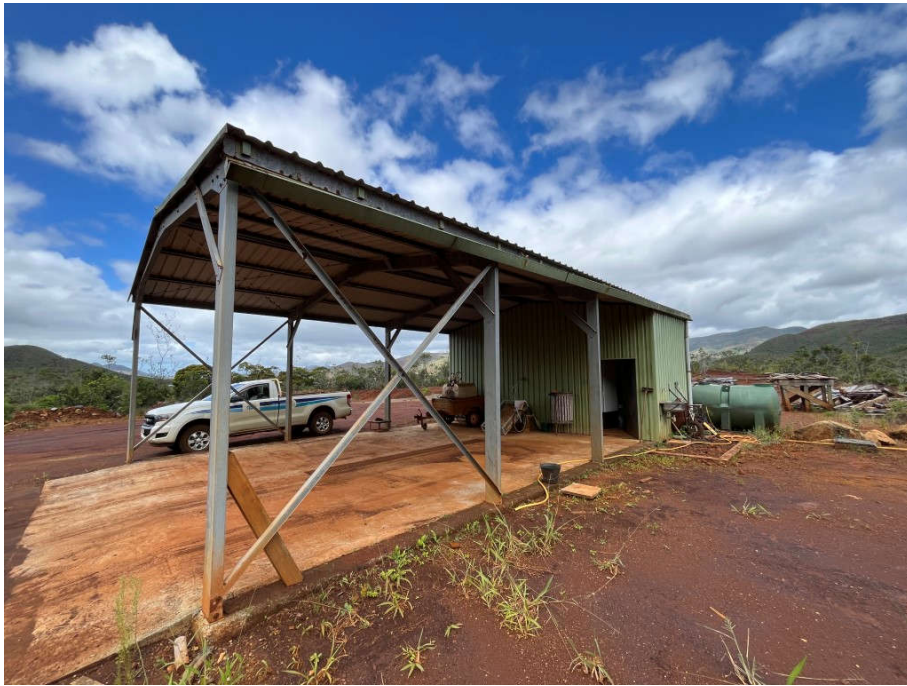
Photos dock du pont Perignon :
