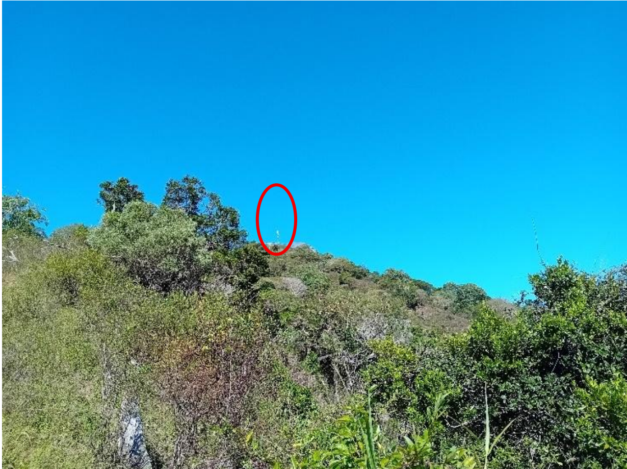
Figure 25 : photo de l'installation depuis la piste d'accès, source : CAPSE NC
