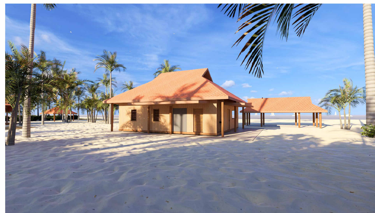
Bâtiment cuisine - façade sud-est
