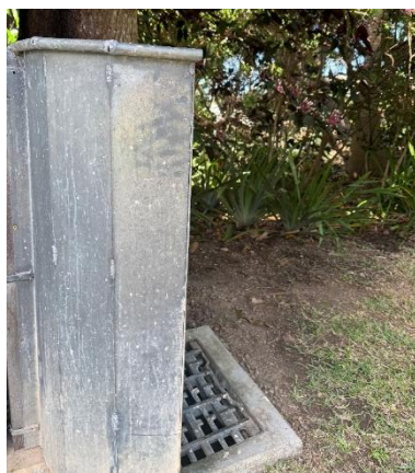
Borne-fontaine existante – Château Hagen
